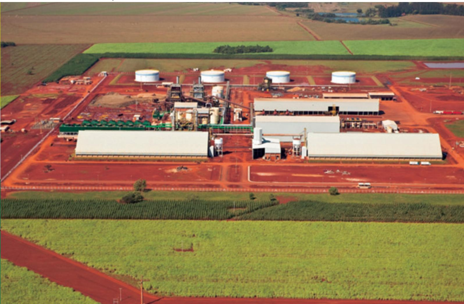
geração e equipamentos fabricados no Brasil. Entre eles, a maior moenda instalada no País, com capacidade para processar 27 mil toneladas de cana-de-açúcar por dia e duas caldeiras de alta eficiência que geram 250 toneladas de vapor por hora. Foram instalados ainda dois armazéns com capacidade para 100 mil toneladas de açúcar cada e quatro tanques de 20 mil metros cúbicos de etanol cada, totalizando 80 mil metros cúbicos.
